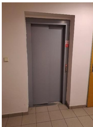
Vstup do výtahu NP
